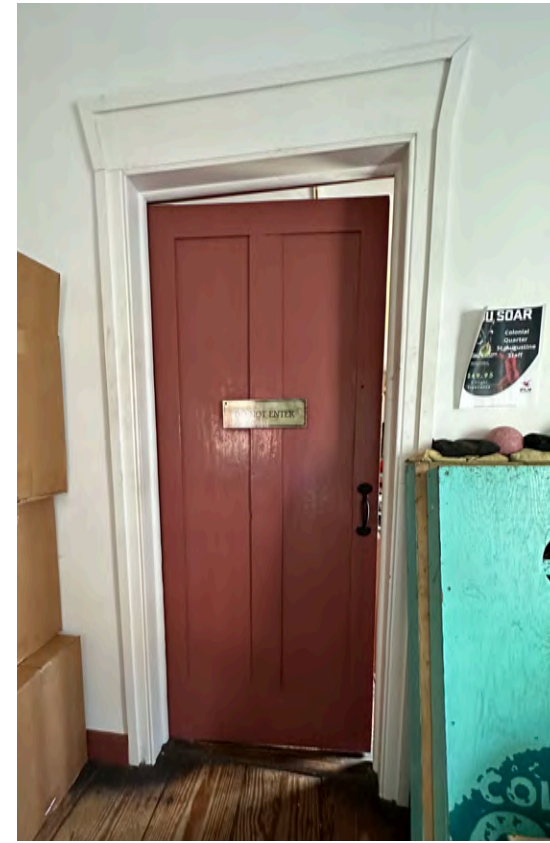
C: Door D19 looking NE
