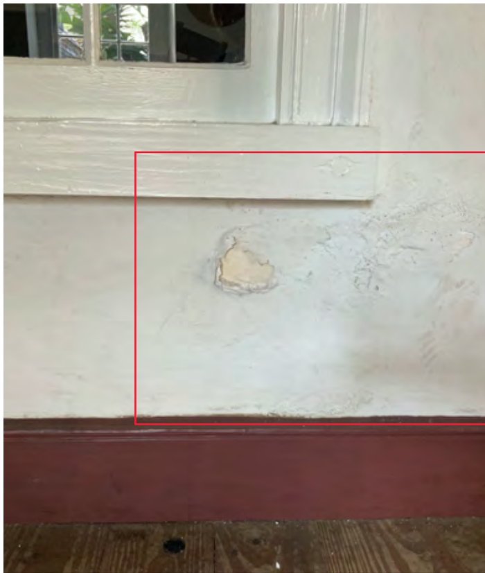
A: Room 107, looking N
