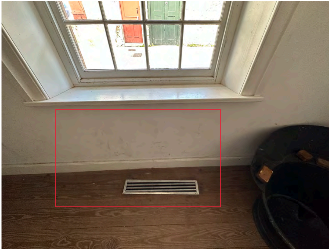
A: Room 103, looking W
