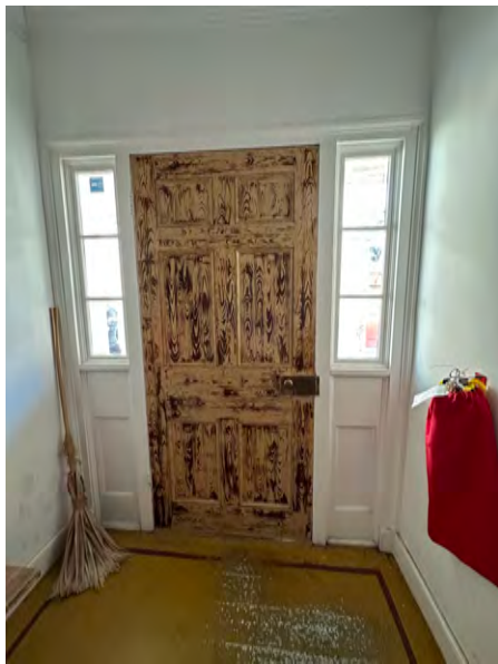
D: Door D1 looking W
