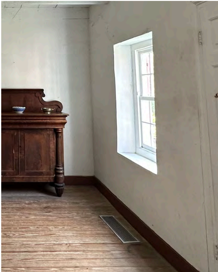
A: Room 107, looking SE
