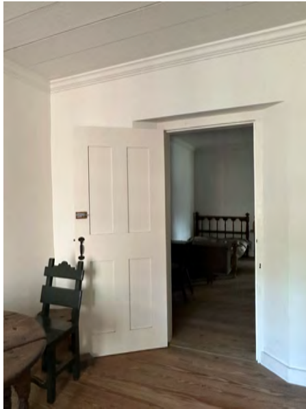
E: Door D5 looking NE
