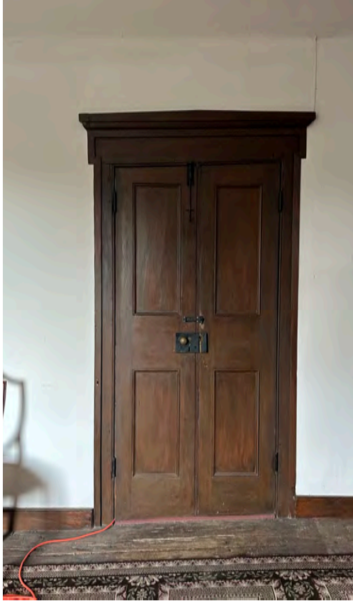
A: Door D14 looking W
